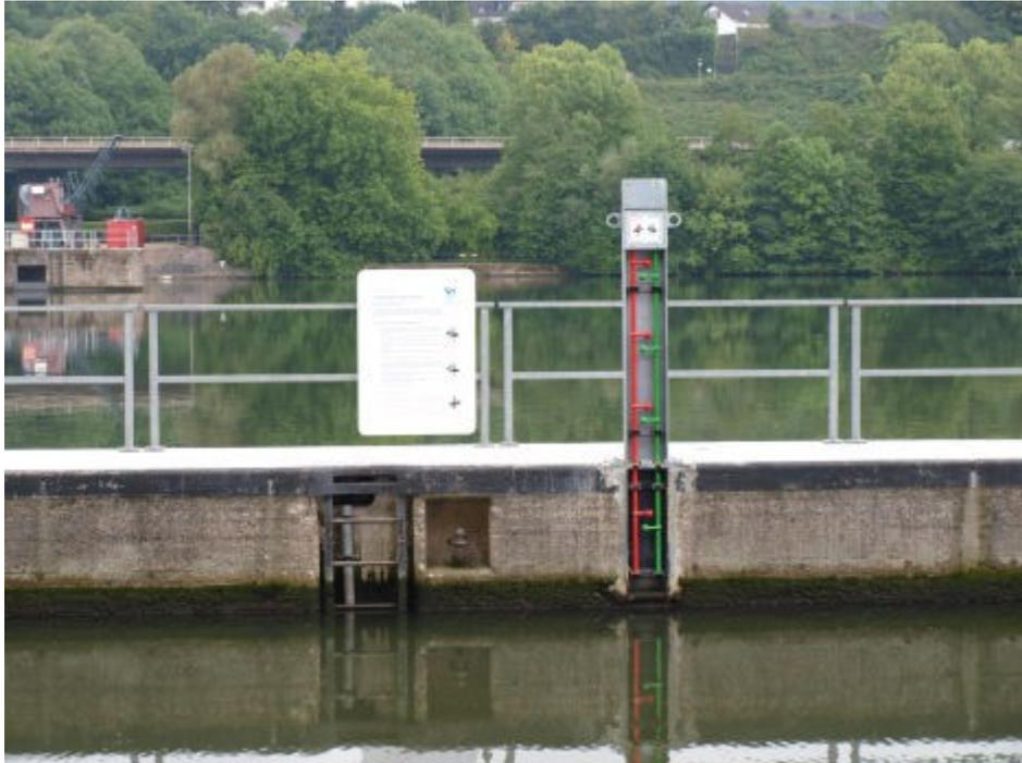
Hier sieht man das wichtigste Bauteil: die Steuerung. Mit dem grünen Hebel wird die Schleusung angefordert.
